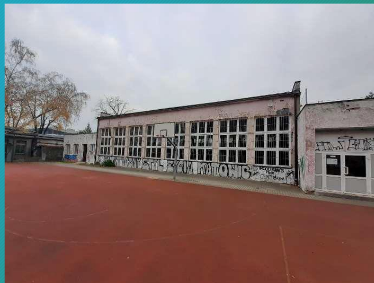
Otoczenie od strony wschodniej (boisko oraz budynek szkoły)
