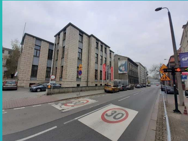
Otoczenie od strony zachodniej (ulica Szkolna oraz zabudowa biurowa i mieszkaniowa wielorodzinna)
